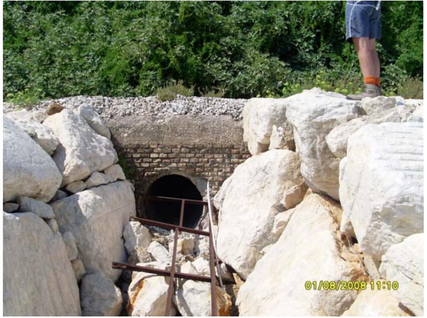
**Ponticello in muratura con volta a botte, su canale di scolo delle acque piovane con parapetto in ferro**
