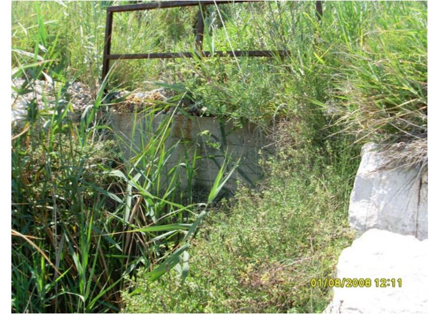
**Ponticello su canale di scolo delle acque piovane in calcestruzzo armato e con parapetto in ferro**
