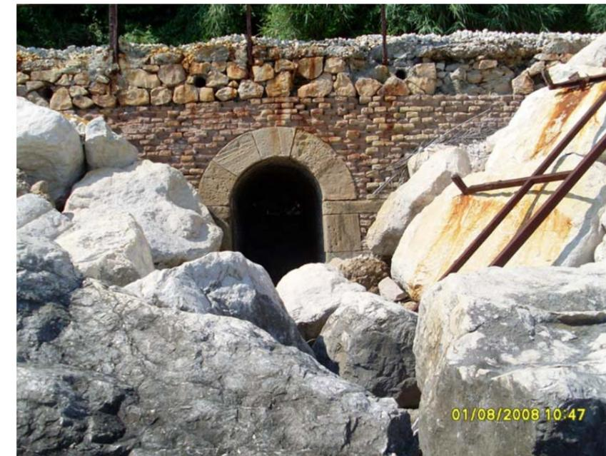
Ponticello a volta a botte in pietra e muratura, su canale di scolo delle acque piovane con parapetto lato mare in ferro
